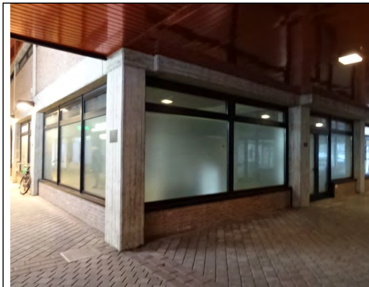
Esterno nord ovest del negozio
