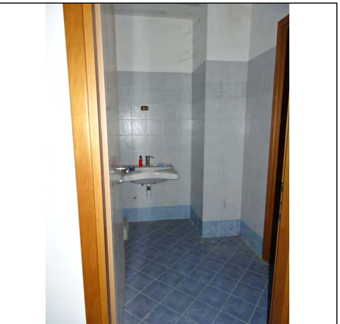
Particolare interno del servizio igienico
