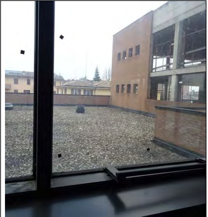
Vista terrazza adiacente piano secondo
